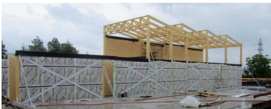
7. Mise en œuvre des murs à ossature bois renforcés
