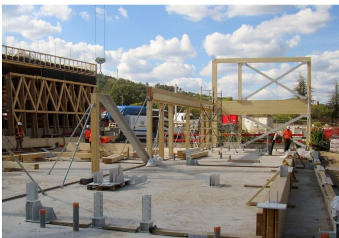
6. Implantation et levage de la structure zone administration
